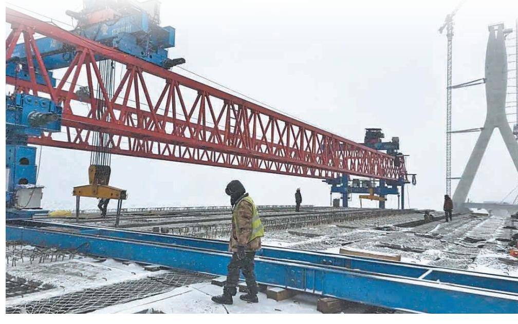
本报讯(记者吴利红)23日,随着最后一片40米预制箱梁在松花江特大桥46号墩精准落位,哈尔滨都市圈北环A2-4标段松花江特大桥预制箱梁全部架设完成,标志着项目主体工程建设取得关键性突破,正式转入桥面系及附属工程施工阶段,向全线贯通目标迈出坚实一步。
