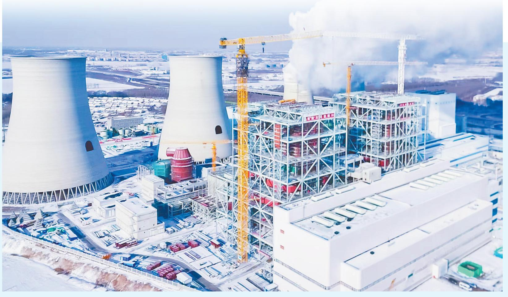
近日,国家能源集团哈尔滨热电厂2X660MW热电联产扩建项目完成主厂房封闭。这意味着厂房内部具备防风防寒条件,可保障冬季连续施工,为后续汽轮机本体安装等工作奠定坚实基础。据悉,该项目是全国首批“两个联营”示范项目,建成后将成为全省装机规模最大的发电企业和城市支撑性主热源,对提升区域供电可靠性、保障城市供暖具有重要意义。
