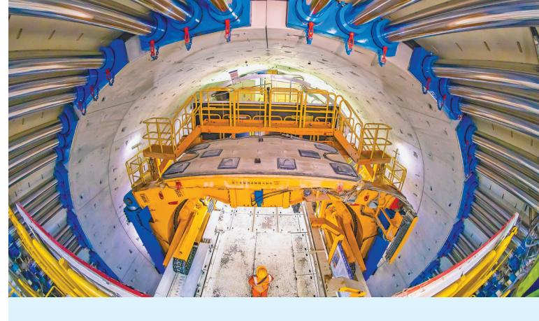
2月6日，在中铁十四局承建的甬舟铁路金塘海底隧道宁波侧施工现场，首台国产盾构饱和带压进仓设备“深海空间站”，成功实施75米深高压环境盾构进仓作业，标志着我国自主研发盾构饱和带压进仓技术成功应用，填补了国内技术空白，为未来深埋跨海隧道建设、深层地下空间开发积累了关键技术储备。
