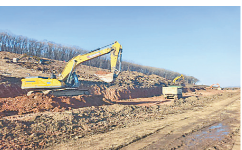
庆安县十六道岗水库工程建设现场。图片由受访单位提供
