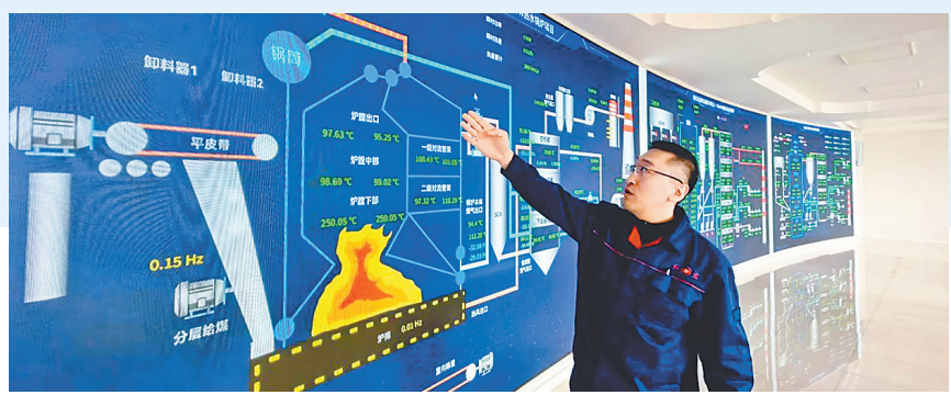
数据中心远程监护锅炉运行。
