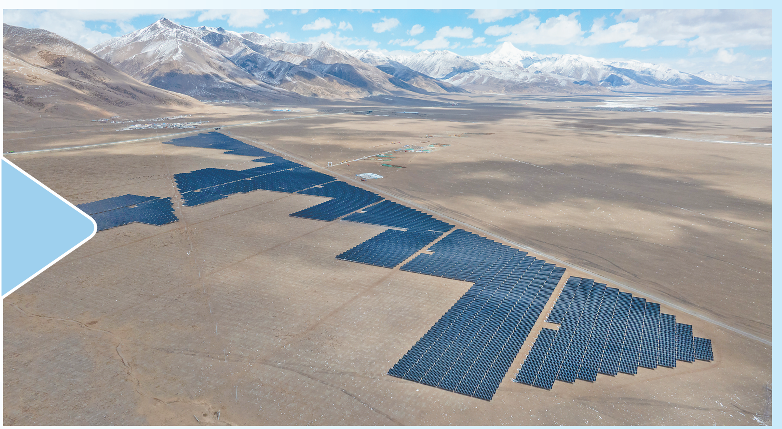
4月6日上午,中广核西藏当雄乌玛塘“光热+光伏”一体化项目中的50兆瓦光热电站在拉萨市当雄县乌玛塘乡正式开工建设。据中广核光热技术型号首席专家尹航介绍,该项目场址海拔4550米,是目前全球海拔最高的槽式光热电站。这是中广核当雄乌玛塘“光热+光伏”一体化项目(4月6日报,无人机照片)。
