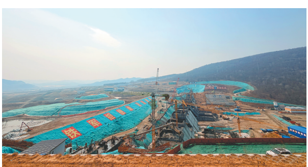
牡丹江市林海水库工程施工现场。本报记者 吴玉玺摄
