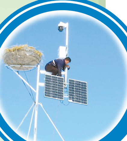
工作人员正在搭建四代铁质三脚架招引巢。
