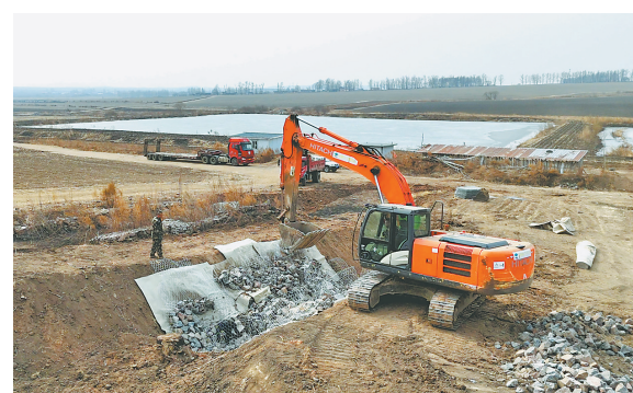
海林农场侵蚀沟治理项目建后管护全面推进中。 刘永立摄
