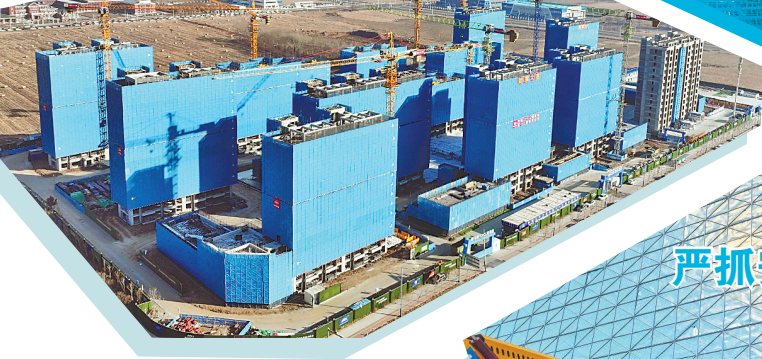
新华村(三家子屯)城中村改造项目回迁安置工程。
