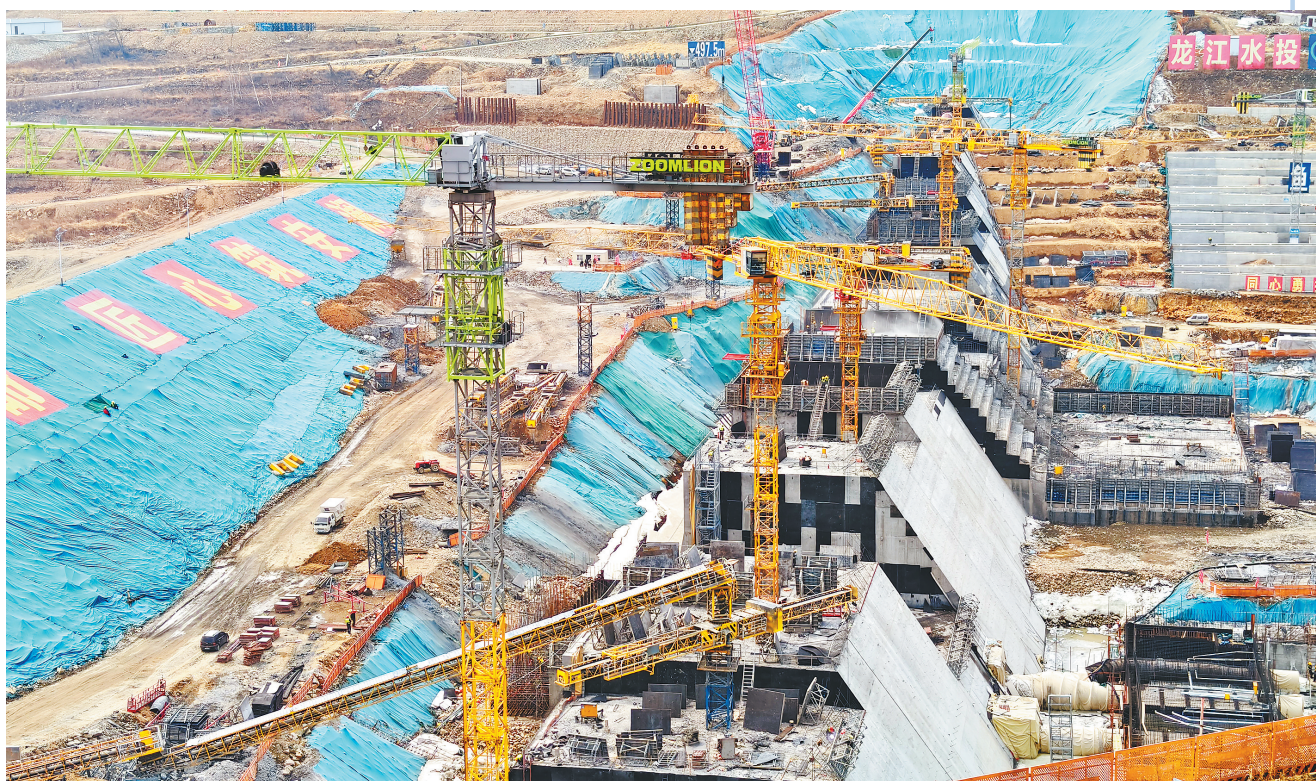
林海水库项目施工现场。
