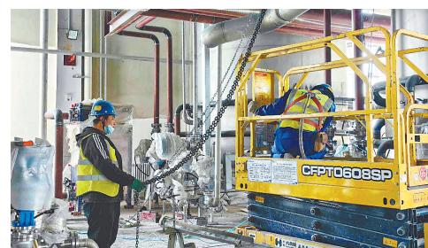
工人们正在进行管线安装。
