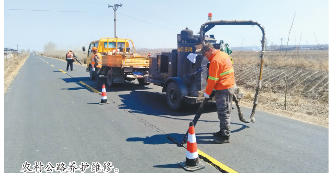
农村公路养护维修。
