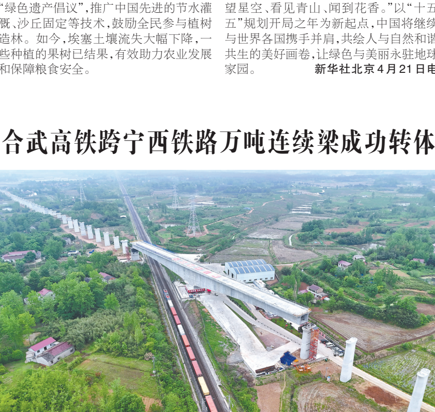
4月21日,在安徽省六安市叶集区境内,由皖赣铁路安徽公司建设管理、中铁十一局承建的四合高铁跨宁西铁路特大桥230米T构连续梁成功完成20.47度“空中转体”,跨越宁西铁路。
