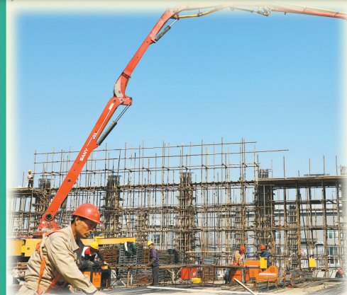
项目开工现场。
