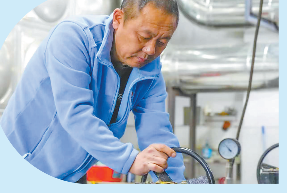
丁昊在检修换热器阀门。
