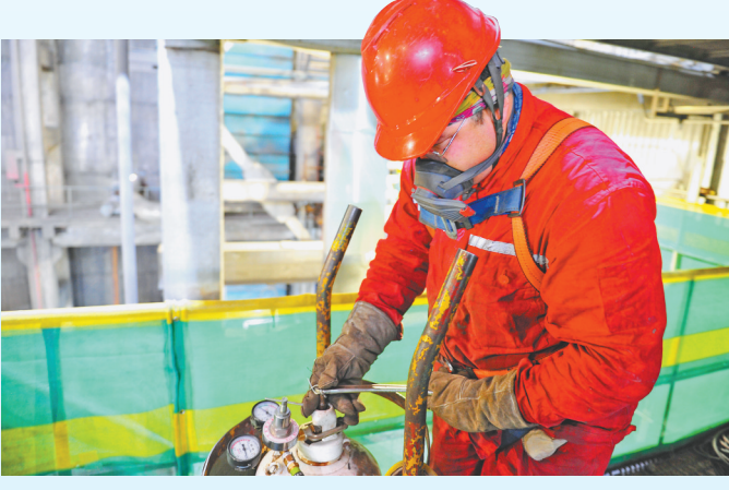
大庆石化热电厂锅炉炉膛治理项目施工现场。李绍志摄
