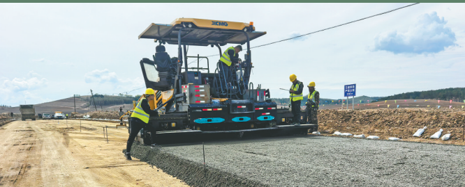
施工近况。 本报记者 张雪地摄
