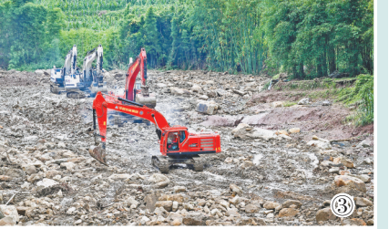
图③:抢险救援现场,大型机械正在作业。
