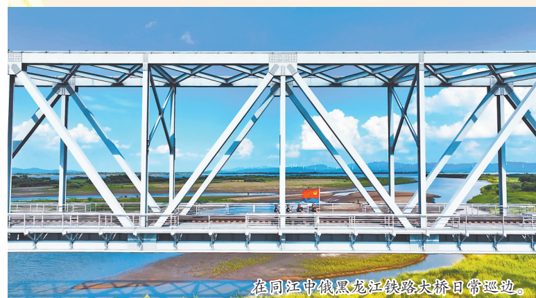
在同江中俄黑龙江铁路大桥日常巡边。
