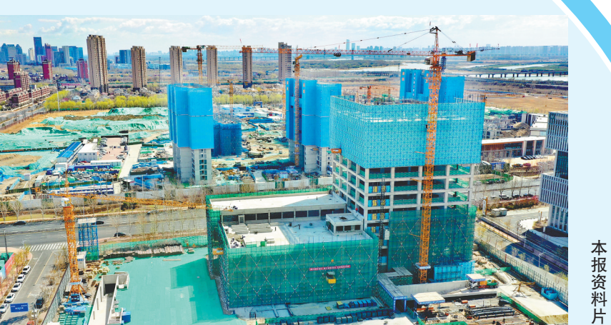
项目建设现场。 本报资料片
