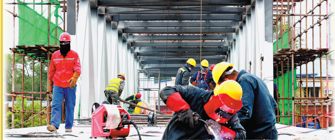
施工人员加紧作业。
