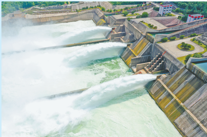
6月22日，小浪底水利枢纽3条排沙洞闸门开启，黄河2026年主汛期前调水调沙随之启动，水库排沙量预计将超1亿吨。这是6月22日在河南济源拍摄的小浪底水利枢纽工程调水调沙现场（无人机照片）。新华社发
