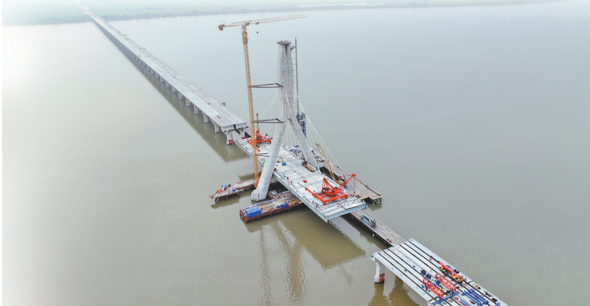
哈尔滨都市圈环线北环项目施工现场。 本报记者 吴利红摄
