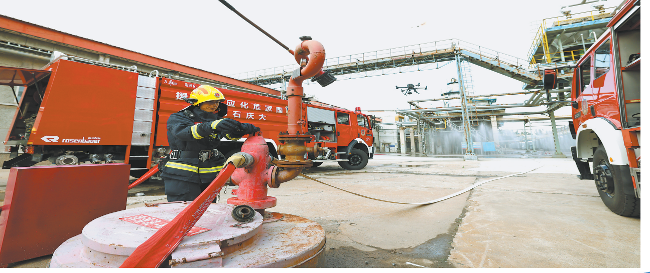
检查消防设施。
