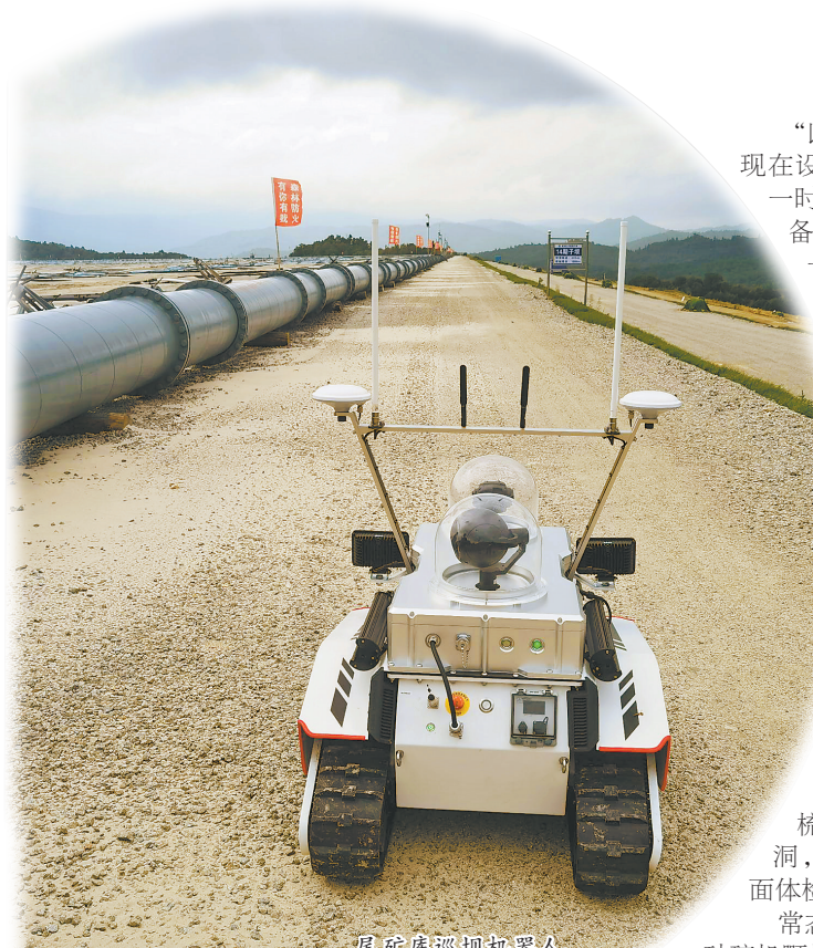
尾矿库巡检机器人。
