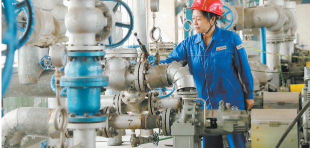
岗位人员使用北斗巡检仪进行巡检。
