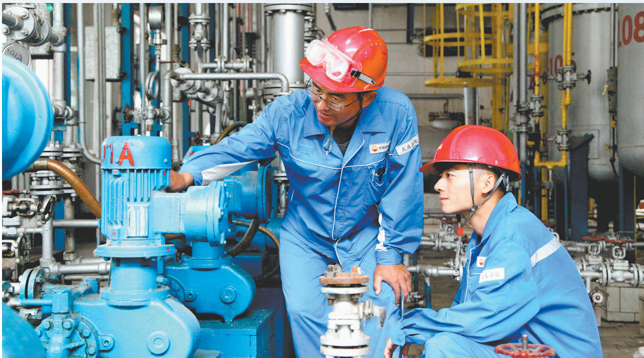
技术人员开展机泵隐患攻关。
