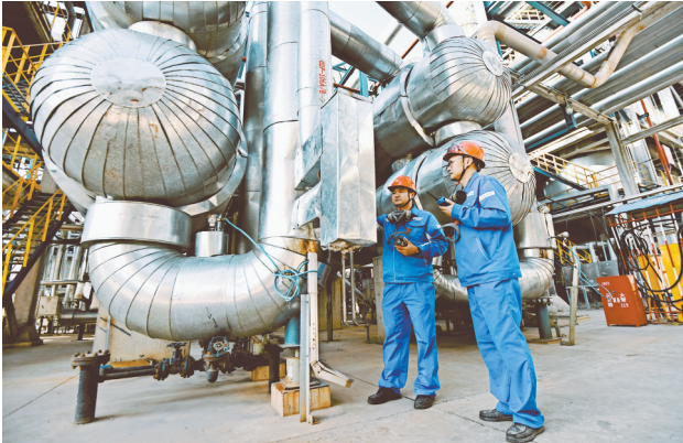
炼油区仪表车间联合属地单位现场“会诊”仪表故障。 杨志明摄
