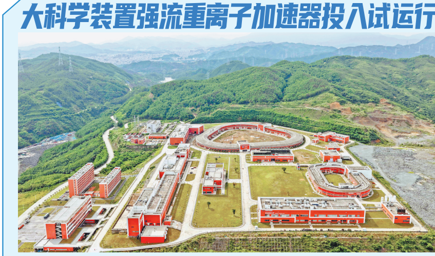
7月21日,位于广东省惠州市的国家重大科技基础设施建设项目——强流重离子加速器装置(HIAF)通过了由中国科学院组织的工艺验收,标志着该装置达到所有工程建设目标,进入试运行阶段。
