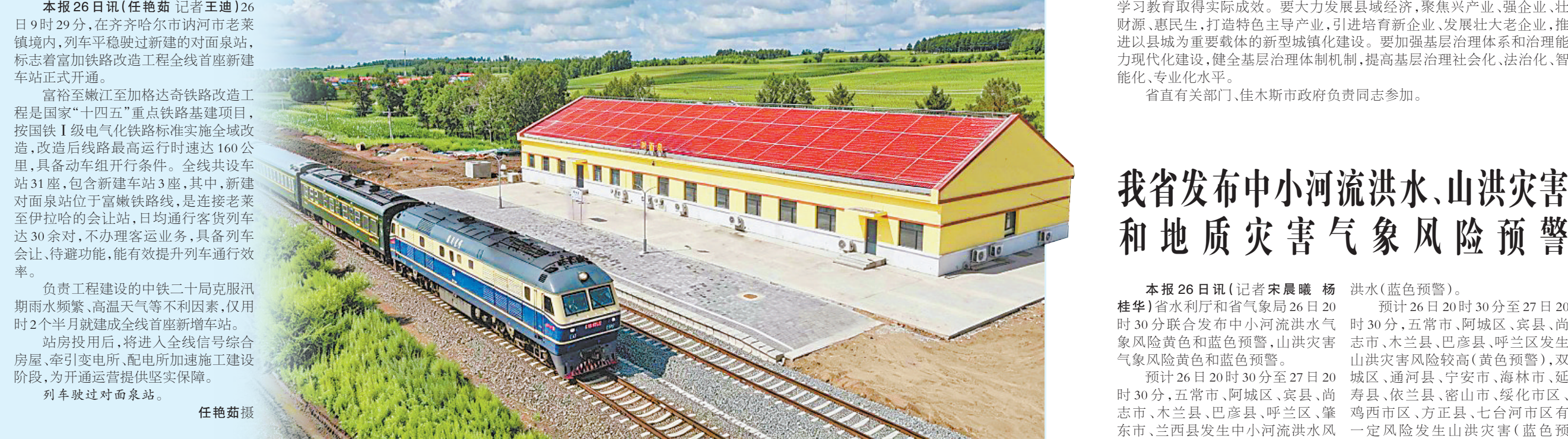
本报26日讯(任艳茹 记者王迪)26日9时29分，在齐齐哈尔市讷河市老莱镇境内，列车平稳驶过新建的对面泉站，标志着富加铁路改造工程全线首座新建车站正式开通。 富裕至嫩江至加格达奇铁路改造工程是国家“十四五”重点铁路基建项目，按国铁Ⅰ级电气化铁路标准实施全域改造，改造后线路最高运行时速达160公里，具备动车组开行条件。全线共设车站31座，包含新建车站3座，其中，新建对面泉站位于富嫩铁路线，是连接老莱至伊拉哈的会让站，日均通行客货列车达30余对，不办理客运业务，具备列车会让、待避功能，能有效提升列车通行效率。 负责工程建设的中铁二十局克服汛期雨水频繁、高温天气等不利因素，仅用时2个半月就建成全线首座新增车站。 站房投用后，将进入全线信号综合房屋、牵引变电所、配电所加速施工建设阶段，为开通运营提供坚实保障。 列车驶过对面泉站。 任艳茹摄
