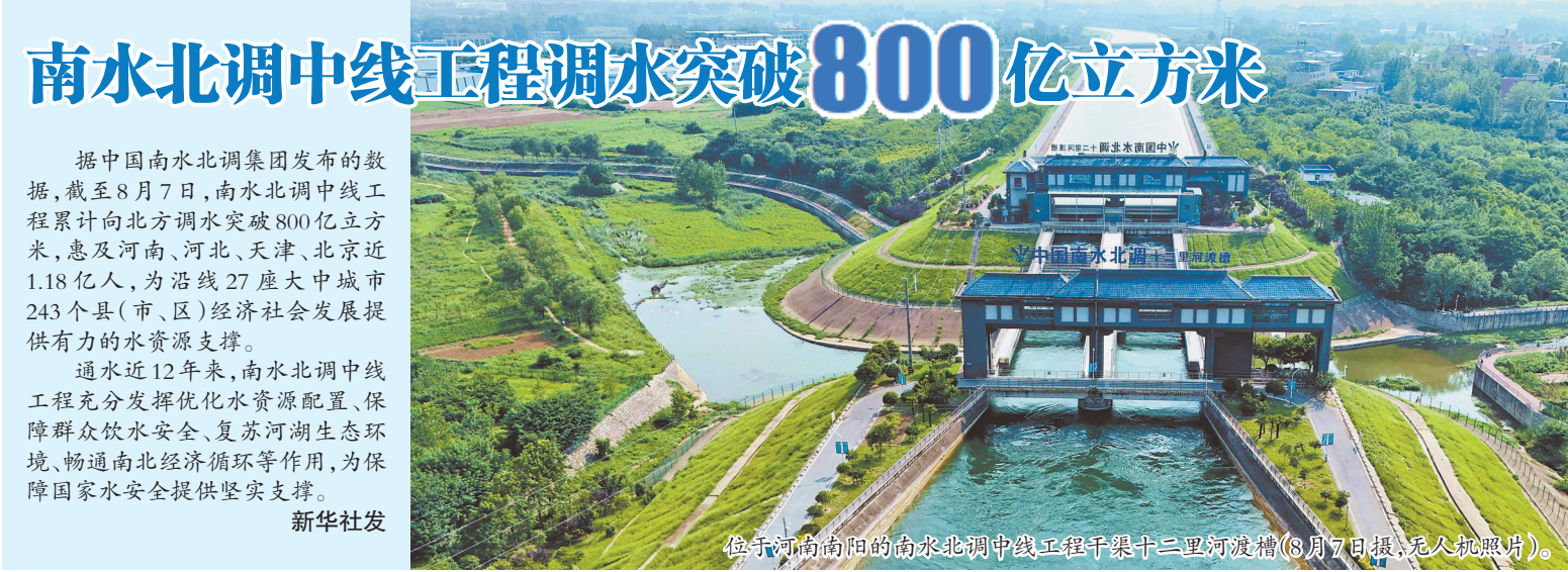
位于河南南阳的南水北调中线工程干渠十二里河渡槽(8月7日摄，无人机照片)。
