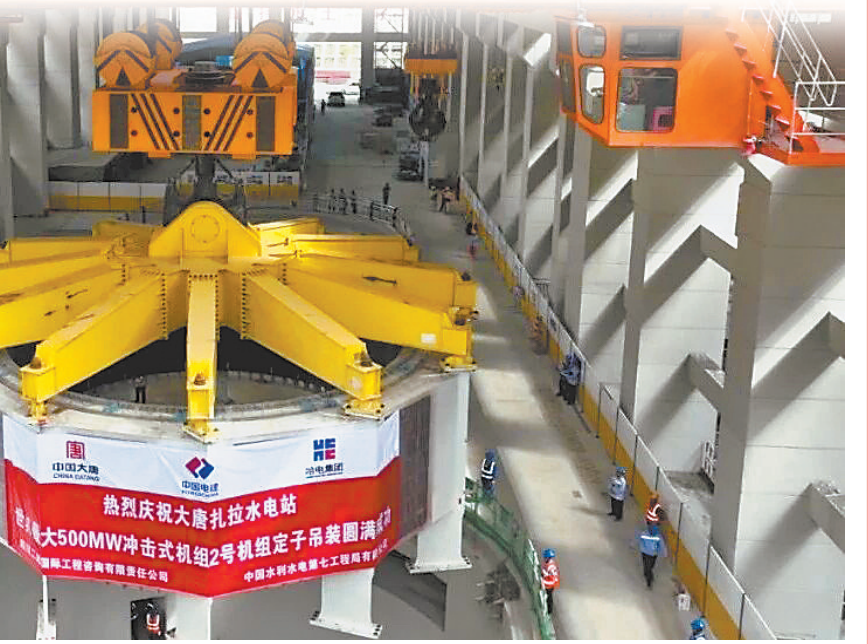
吊装全球单机容量最大冲击式机组定子。 图片由受访单位提供 奋进“十五五” 阔步向未来
