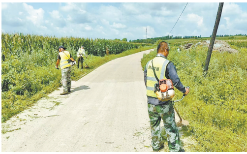
道路除草作业现场。
