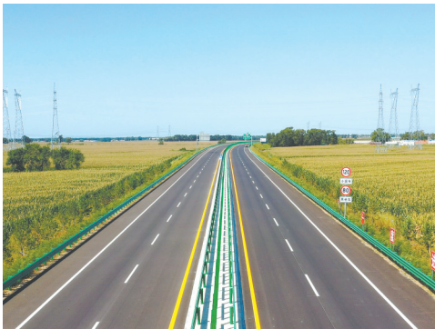
沥青混凝土路面全线贯通。图片由受访单位提供
