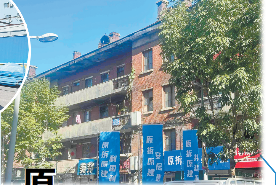
拆除前的人和街 172—174 号。
