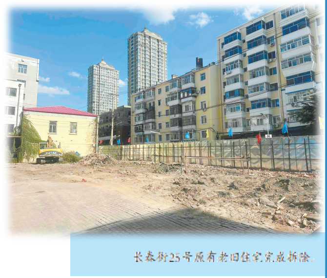
长春街 25 号原有老旧住宅完成拆除。
