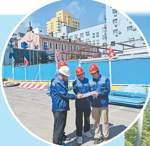
施工人员查看施工图。
