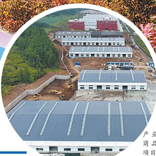
国际物流产业园进出口商品集散中心项目建设现场。
