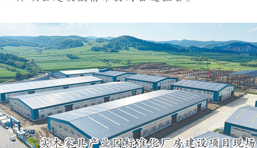
实木家具产业园标准化厂房建设项目现场。
