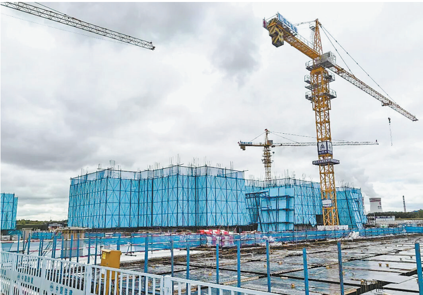
城中村项目施工现场。
