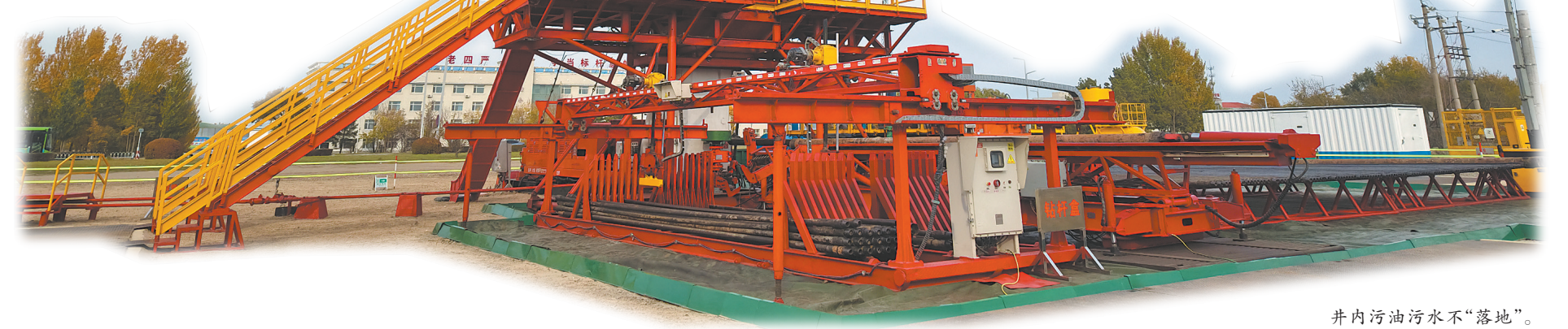
井内污油污水不“落地”。
