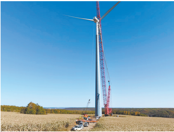
项目建设现场。
