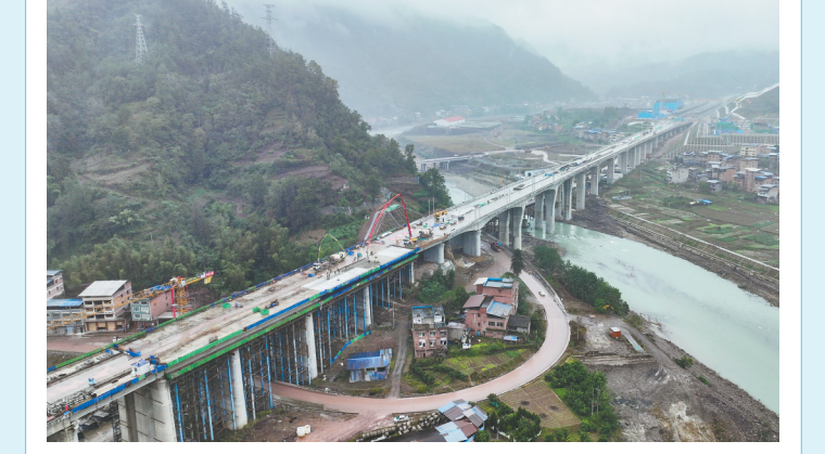
10月27日,随着最后一方混凝土的浇筑完成,西渝高铁康渝段樊哙站2号六线特大桥顺利实现合龙,为全线如期通车奠定了坚实基础。樊哙站2号六线特大桥位于四川省达州市宣汉县,全长1207.3米,承担着西渝高铁正线与万州支线的连通功能。西渝高铁是国家“八纵八横”高速铁路网中京昆通道、包(银)海通道的重要组成部分。这是10月27日拍摄的西渝高铁樊哙站2号六线特大桥建设现场(无人机照片)。 新华社记者 王曦摄
