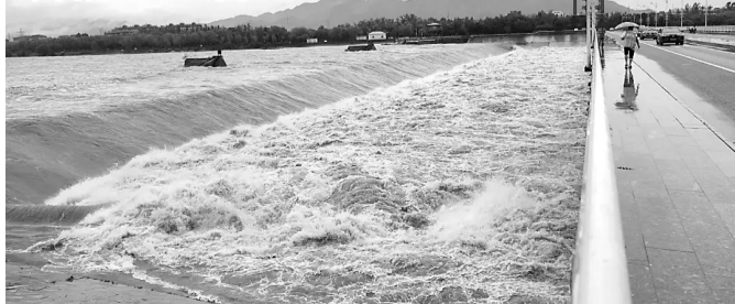
7月29日上午,密云水库下游泄流现场,潮河、白河交汇处水声震耳欲聋,水面宽近300米。
