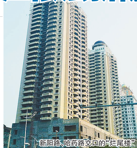
新阳路哈药路交回的“烂尾楼”
