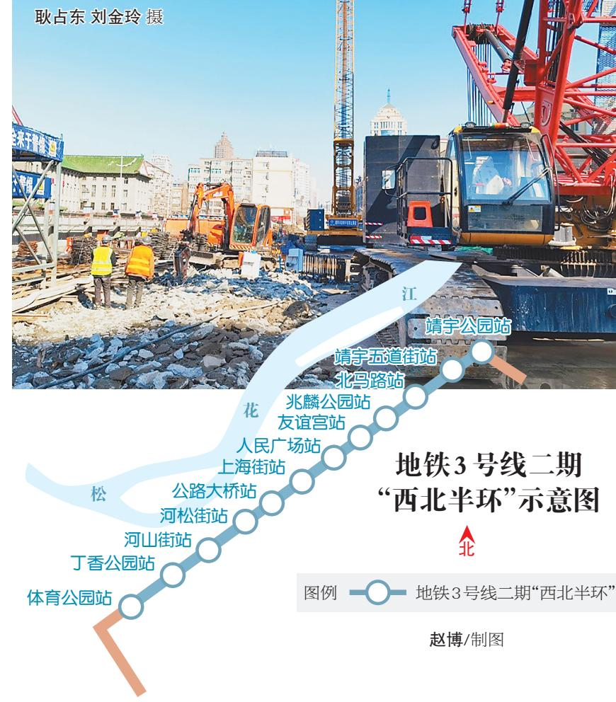
生活报讯(耿占东 刘金玲 记者赵政)哈尔滨地铁3号线二期工程作为我省“百大项目”之一,历来深受广大市民的关注。13日,记者走进道里区友谊路上的地铁3号线上海街站看到,这里正在进行“地连墙”施工,轰鸣的成槽机将地下47米深的泥土吊运上来,装进大货车……目前,3号线二期“西北半环”12座车站已经全面复工复产,比计划开工时间提前15天。
