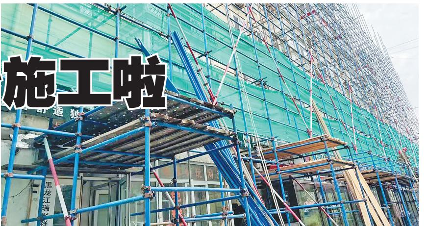
小区纳入改造范围，改造建筑面积约为49.43万平方米，改造楼体70栋，改造单元357个，涉及户数7911户。改造内容包括粘贴保温板、墙体粉刷、外挂线梳理、屋面防水、更换单元门、楼道工程、供热管线、供水管线等。
