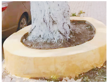
人员安排维修班组进行维修,现已将树池维修、粉饰完毕。
