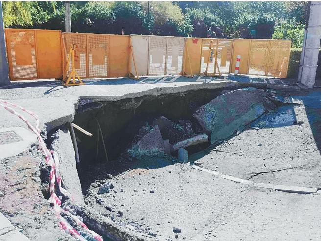
生活报讯 (记者肖劲彪文/摄) 28日23时许,哈尔滨市道里区群力第一大道与景江东路交口处的人行道发生塌陷,地面两台车坠入坑中。经调查,塌陷因排水管线渗漏造成,目前正在抢修。
