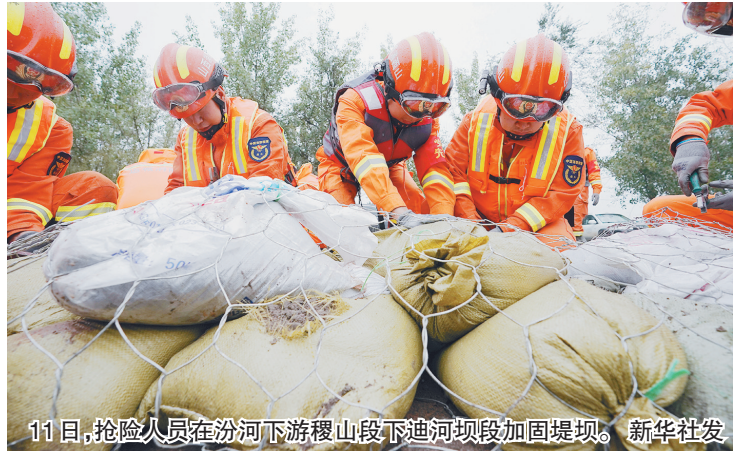
11日,抢险人员在汾河下游穆山段下迪河坝段加固堤坝。新华社发
