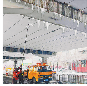
桥、地下隧道昼夜不间断循环反复清理。
