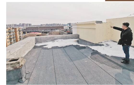
郑先生家楼顶拆除违建后
