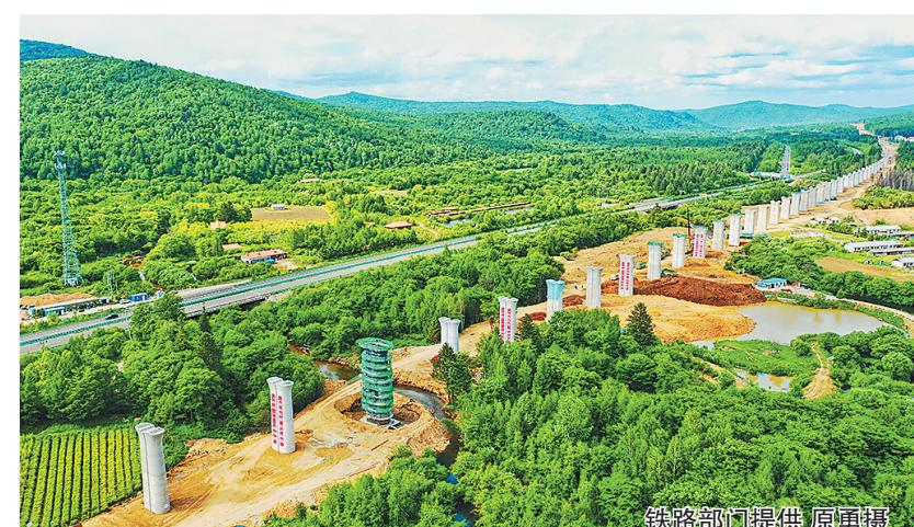
生活报讯（记者栾德谦）记者从中国铁路哈尔滨局集团有限公司获悉，14日在哈伊高铁铁力至伊春段解放3号大桥施工现场，随着最后一根桩基混凝土浇筑完成，标志着我国最北端高铁哈伊高铁铁伊段先行工程桥梁桩基项目顺利完工，创新冻土段钻孔桩施工的双层护筒结构施工经验，完成了国内首例高铁桥梁多年冻土桩基施工。
