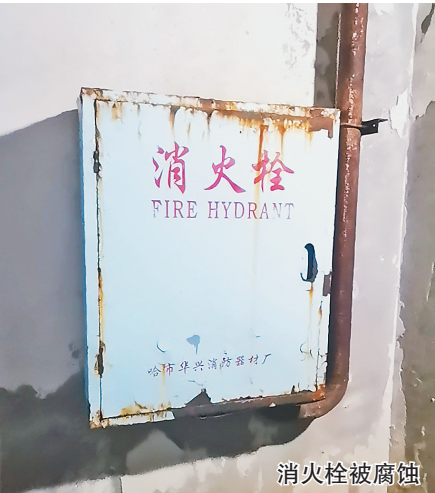
消火栓被腐蚀
