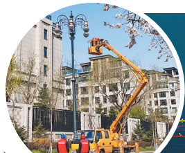
工作人员在维护路灯设备
